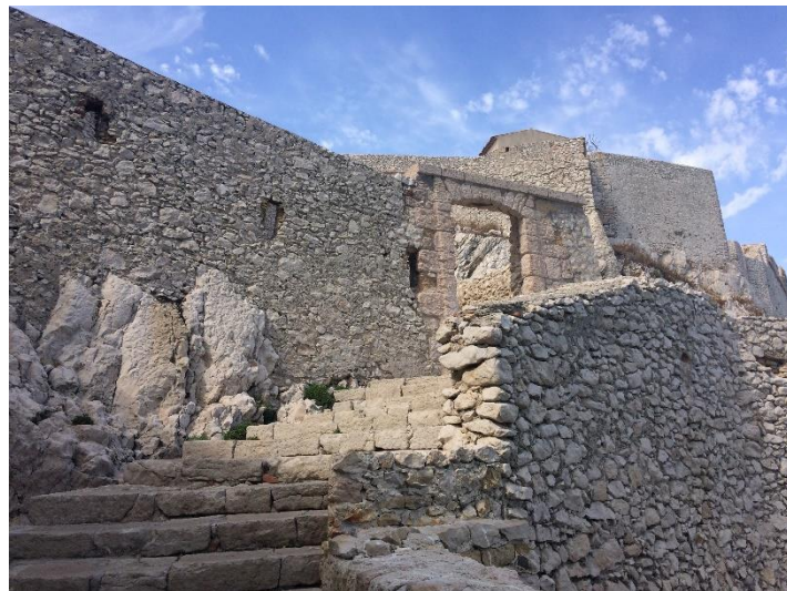
04. Détail de la construction de la construction de l'enceinte (rocher, remblais, pierres taillées)
