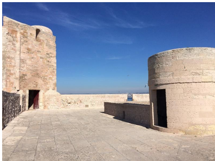
03. Dalles de la terrasse en pierre du midi
