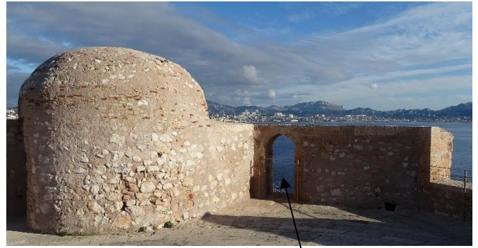
07. Ouverture pour l'écoulement des eaux
