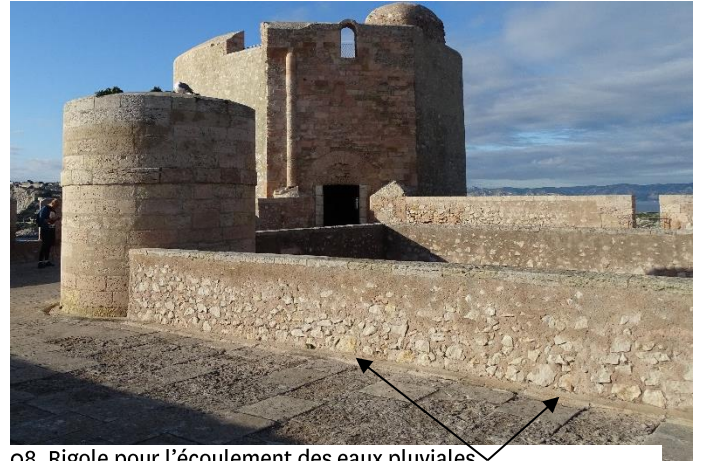
08. Rigole pour l'écoulement des eaux pluviales
